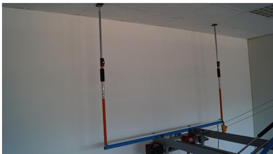
12. Die mitgelieferten Baustützen in die dafür vorgesehene Öffnung einstecken und mit dem Sicherungsstift sichern.
