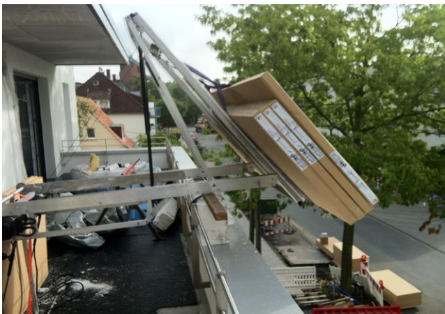
Einsatz im zusammengeklappten Zustand auf dem Gerüst, Heckseite wird im Beton verankert
