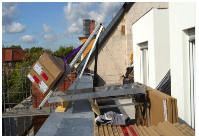
Einsatz im zusammengeklappten Zustand auf dem Gerüst, Heckseite wird im Beton verankert
