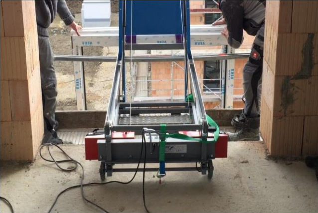
Einsatz im zusammengeklappten Zustand auf dem Gerüst, Heckseite wird im Beton verankert
