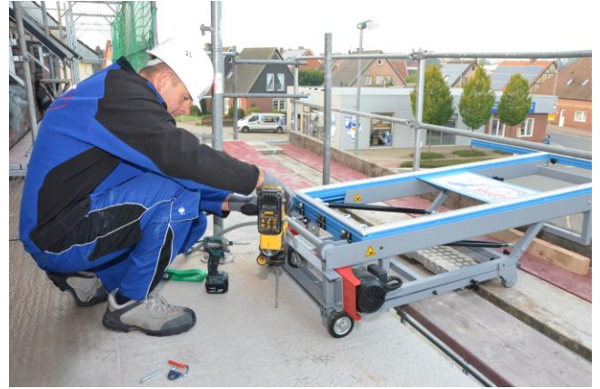
Einsatz im zusammengeklappten Zustand auf dem Gerüst, Heckseite wird im Beton verankert
